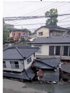
地震による倒壊
